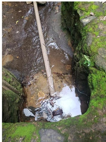
FIGURA 104 – TOMADA D'ÁGUA DA BARRAGEM DE ACUMULAÇÃO
