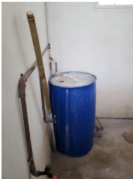
FIGURA 114 – SISTEMA DE TRATAMENTO COM CLORO
