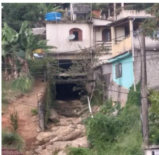
FIGURA 621 – EDIFICAÇÃO SOBRE GALERIA DE ÁGUA PLUVIAL
