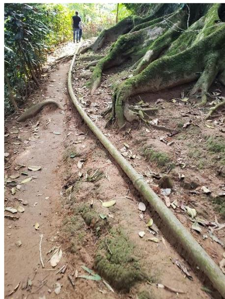
FIGURA 268 – REDE DE ADUÇÃO QUE INTERLIGA OS RESERVATÓRIOS SUPERIORES E INFERIORES
