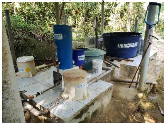
FIGURA 55 – VISÃO INTERNA CLORADOR
