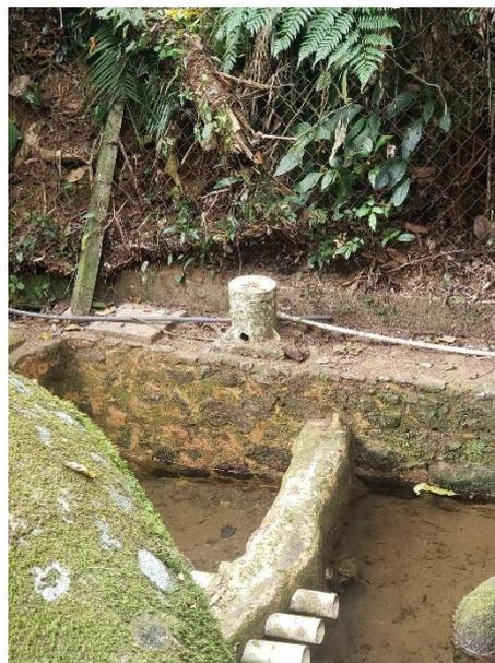
FIGURA 78 – BARRAGEM DE ACUMULAÇÃO DE FIGURA 79 – CLORADOR DA BARRAGEM DE ACUMULAÇÃO
