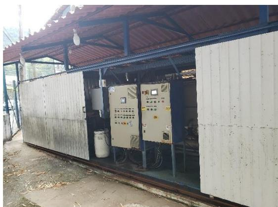
FIGURA 532 – ETE – TRATAMENTO FÍSICO-QUÍMICO – QUADROS ELÉTRICOS
