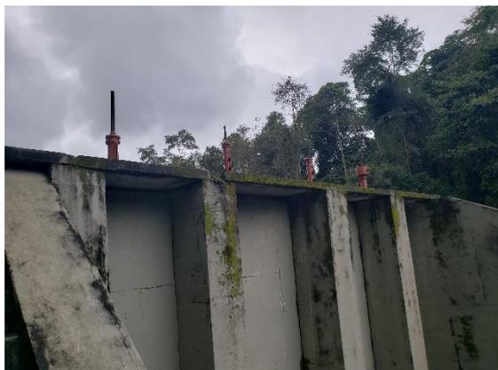
FIGURA 168 – BARRAGEM DE ACUMULAÇÃO BANQUETA – MECANISMO DE ACIONAMENTO DAS COMPORTAS
