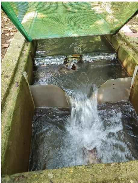
FIGURA 321 – SISTEMA DE TRATAMENTO – FILTRO E VERTEDOR TRIANGULAR
