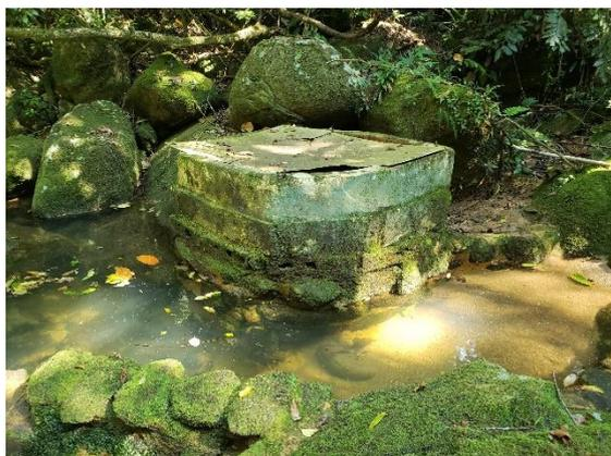
FIGURA 315 – BARRAGEM DE ACUMULAÇÃO COM TOMADA D'ÁGUA
