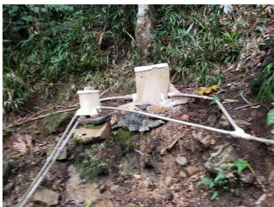
FIGURA 100 – SISTEMA DE CLORAÇÃO DA BARRAGEM DE ACUMULAÇÃO
