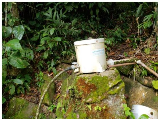
FIGURA 209 – CLORADOR DA BARRAGEM DE ACUMULAÇÃO
