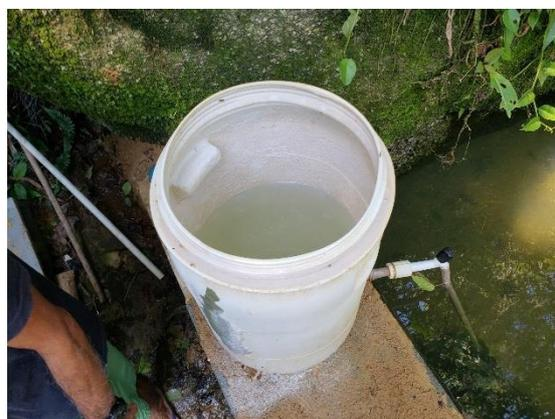
FIGURA 364 – CLORADOR – BARRAGEM DE ACUMULAÇÃO
