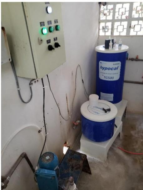
FIGURA 113 – SISTEMA DE TRATAMENTO COM CLORO
