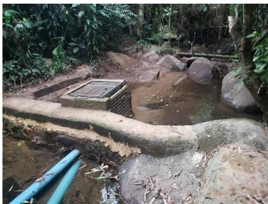
FIGURA 69 – GRADEAMENTO DA BARRAGEM DE ACUMULAÇÃO 01
