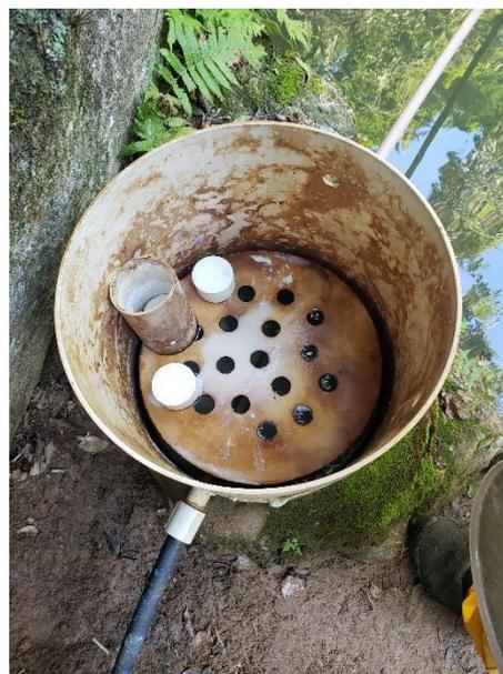
FIGURA 374 – CLORADOR DA BARRAGEM DE ACUMULAÇÃO
