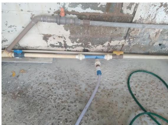
FIGURA 203 – APLICAÇÃO DE CLORO POR MEIO DO TUBO VENTURI
