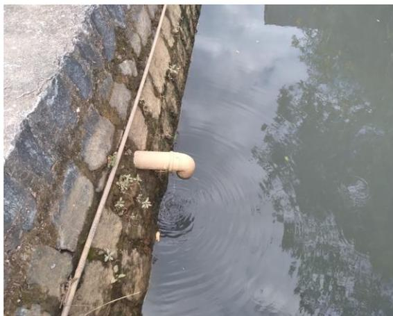
FIGURA 619 – LANÇAMENTO DE ESGOTO EM CANAL DE DRENAGEM
