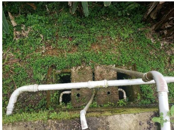
FIGURA 125 – SISTEMA DE EXTRAVASÃO E DISTRIBUIÇÃO DO RESERVATÓRIO DE ÁGUA
