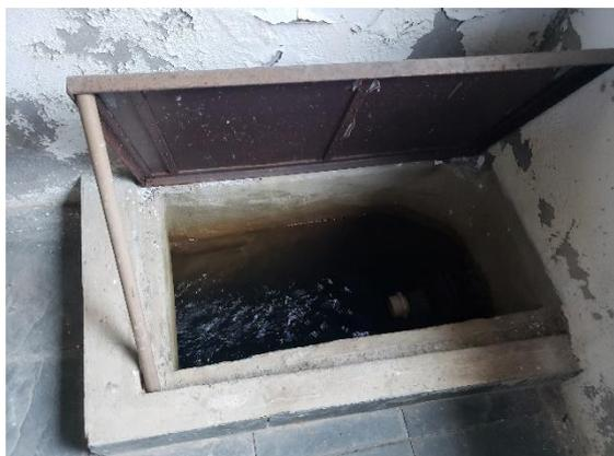
FIGURA 250 – POÇO DE SUCÇÃO
