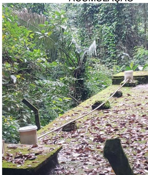
FIGURA 106 – CLORADORES DO RESERVATÓRIO
