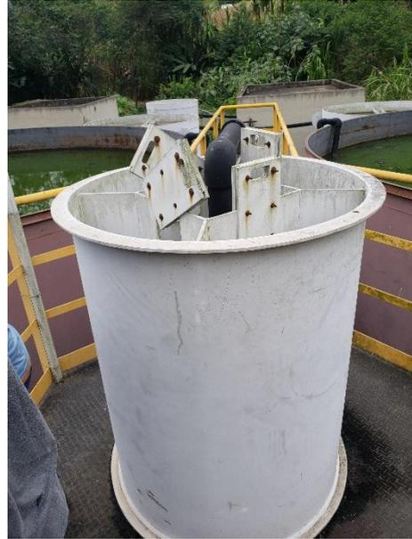
FIGURA 464 – CAIXA DE DISTRIBUIÇÃO DOS TANQUES DE AERAÇÃO
