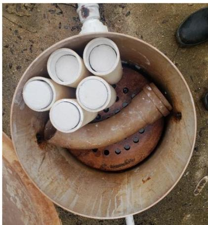
FIGURA 124 – CLORADOR DE RESERVATÓRIO DE ÁGUA
