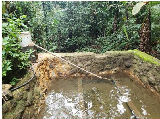
FIGURA 214 – BARRAGEM DE ACUMULAÇÃO COM CLORAÇÃO
