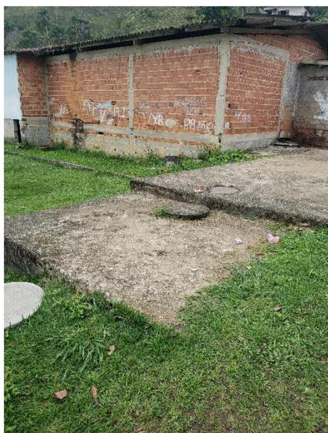
FIGURA 448 – SISTEMA FOSSA SÉPTICA E FILTRO ANAERÓBIO
