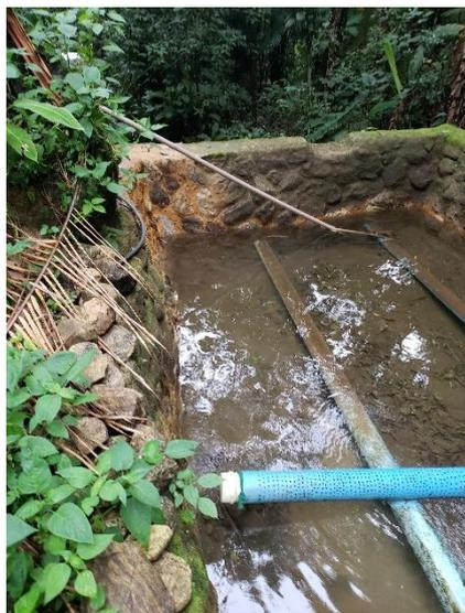
FIGURA 215 – DETALHA DO TUBULAÇÃO DE TOMADA D'ÁGUA NA BARRAGEM DE ACUMULAÇÃO
