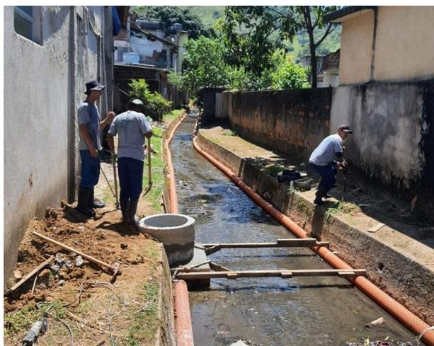
FIGURA 561 – IMPLANTAÇÃO DE REDE DE ESGOTO EM CANAL DE DRENAGEM
