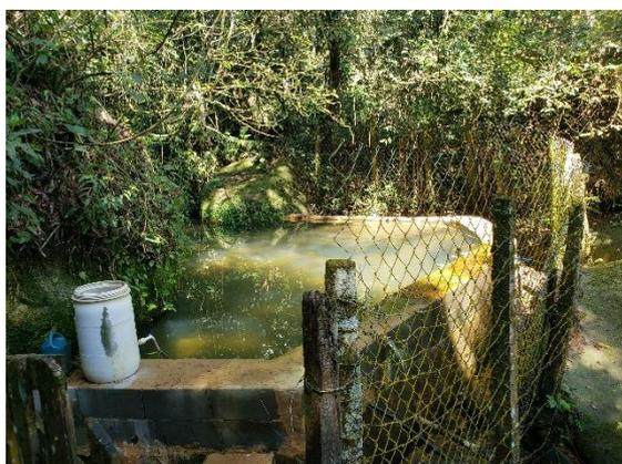
FIGURA 363 – ADIÇÃO DE CLORO NA BARRAGEM DE ACUMULAÇÃO
