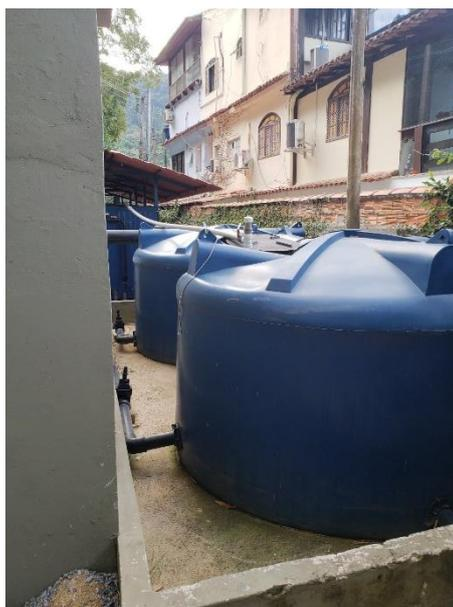
FIGURA 529 – ETE – TANQUES DE EQUALIZAÇÃO
