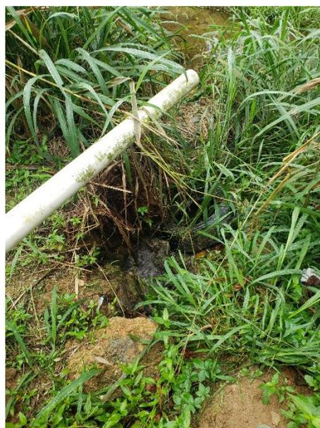
FIGURA 449 – LANÇAMENTO DE ESGOTO EM TERRENO
