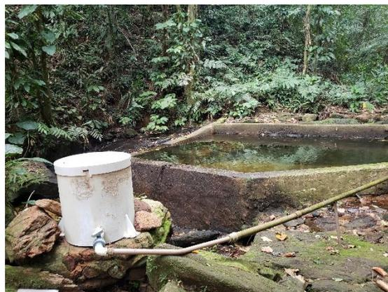
FIGURA 93 – CLORADOR DA BARRAGEM DE ACUMULAÇÃO
