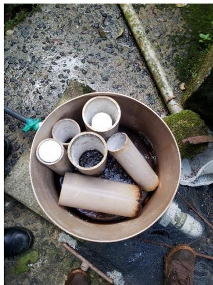
FIGURA 266 – CLORADOR DA CAIXA DE TRATAMENTO 02
