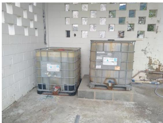
FIGURA 204 – BOMBONAS DE FLUOR PARA APLICAÇÃO NA ÁGUA A SER DISTRIBUIDA
