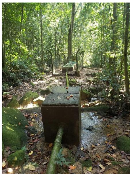
FIGURA 318 – SISTEMA DE TRATAMENTO – CAIXA DE PASSAGEM
