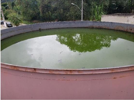
FIGURA 463 – TANQUE DE AERAÇÃO
