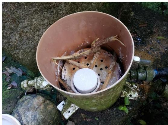
FIGURA 264 – CLORADOR DA CAIXA DE TRATAMENTO 01
