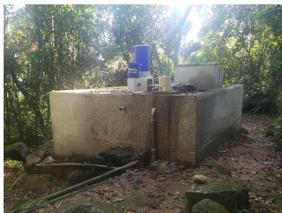
FIGURA 334 – RESERVATÓRIO COM SISTEMA DE CLORAÇÃO
