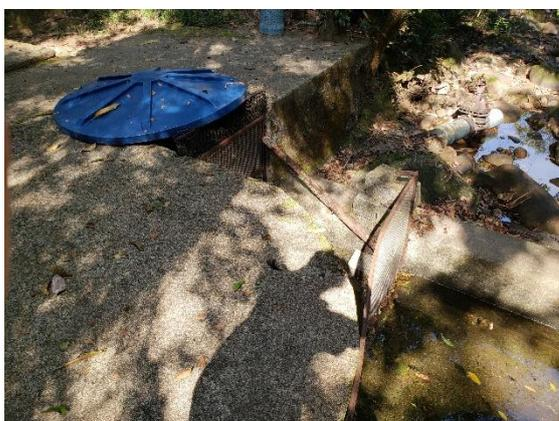
FIGURA 52 – GRADEAMENTO DA BARRAGEM DE ACUMULAÇÃO
