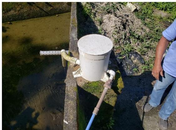
FIGURA 237 – CLORADOR DA BARRAGEM
