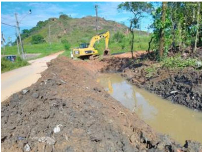
FIGURA 604 – DESASSOREAMENTO DE CURSO D'ÁGUA NO BAIRRO BELÉM
