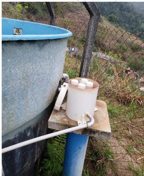
FIGURA 134 – CLORADOR DO RESERVATÓRIO SUPERIOR
