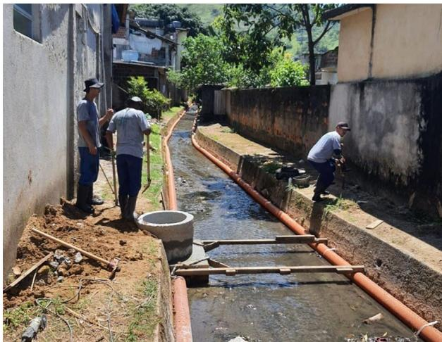
FIGURA 6-170 – IMPLANTAÇÃO DE REDE DE ESGOTO EM CANAL DE DRENAGEM
