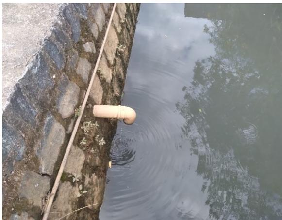
FIGURA 7-16 – LANÇAMENTO DE ESGOTO EM CANAL DE DRENAGEM
