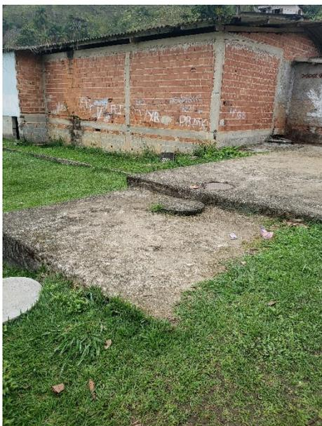
FIGURA 6-58 – SISTEMA FOSSA SÉPTICA E FILTRO ANAERÓBIO
