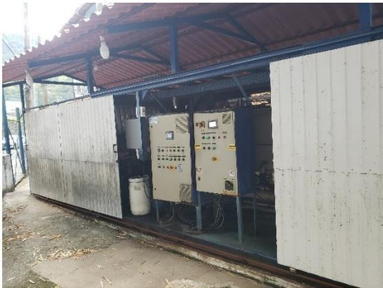
FIGURA 6-141 – ETE – TRATAMENTO FÍSICO-QUÍMICO – QUADROS ELÉTRICOS
