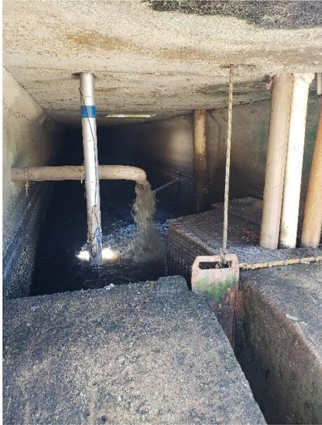
FIGURA 6-108 – EEE ANIL - POÇO DE SUCÇÃO COM GRADEAMETNO
