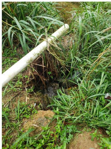
FIGURA 6-59 – LANÇAMENTO DE ESGOTO EM TERRENO
