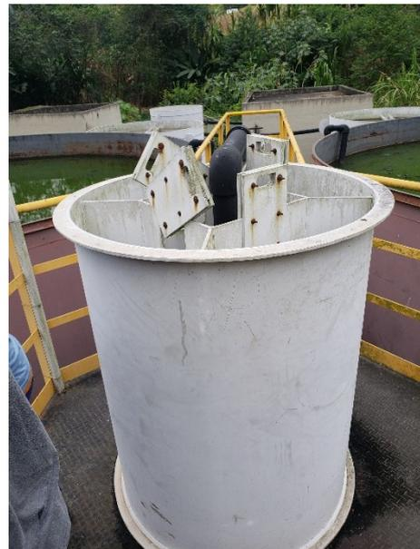
FIGURA 6-73 – CAIXA DE DISTRIBUIÇÃO DOS TANQUES DE AERAÇÃO
