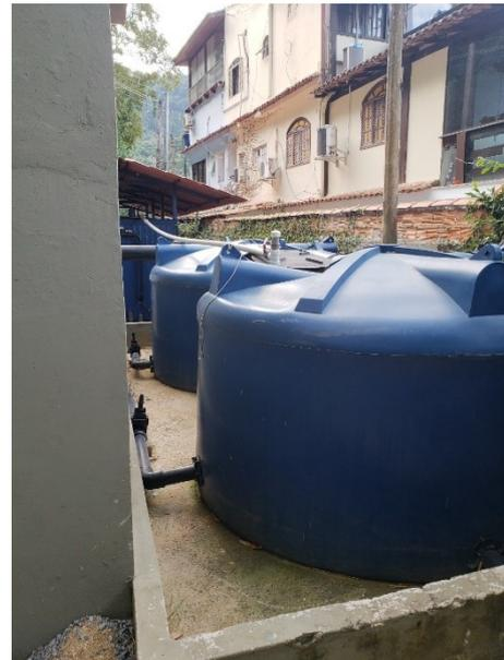
FIGURA 6-138 – ETE – TANQUES DE EQUALIZAÇÃO
