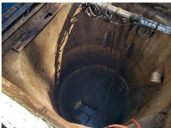
FIGURA 6-184 – EEE 06 – POÇO DE SUCÇÃO
