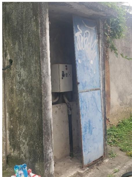
FIGURA 6-82 – EEE ALVORADA – ABRIGO DE QUADRO ELÉTRICO
