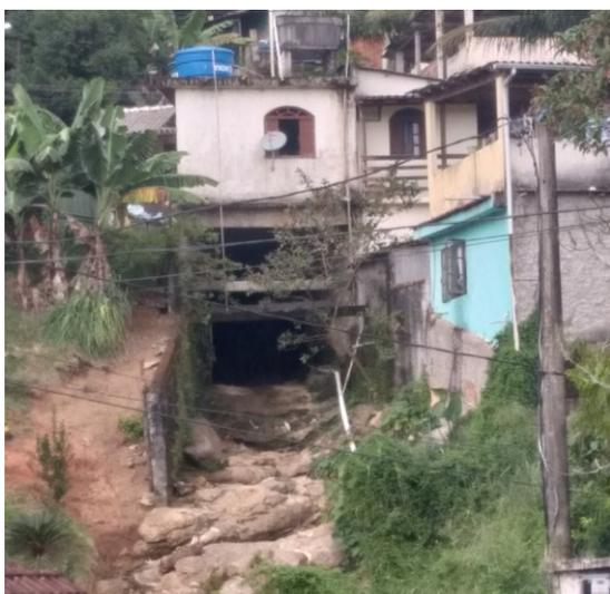
FIGURA 7-18 – EDIFICAÇÃO SOBRE GALERIA DE ÁGUA PLUVIAL
