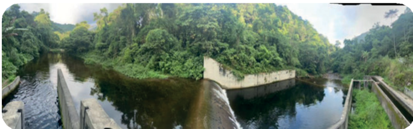
Foto 1 – Captação de água da Banqueta, Angra dos Reis/RJ. Foto: CBH-BIG
