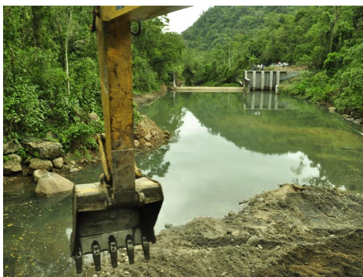
Figura 4.2 - Obras de dragagem realizadas no reservatório da Banqueta em 2015
