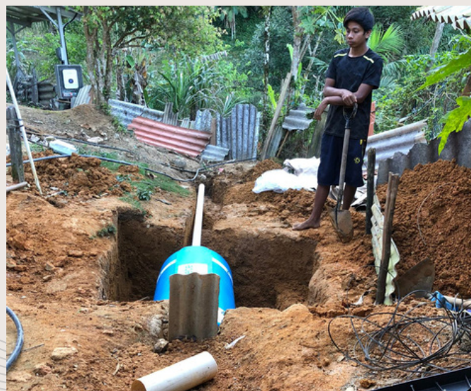
Instalação do sistema Bioete
