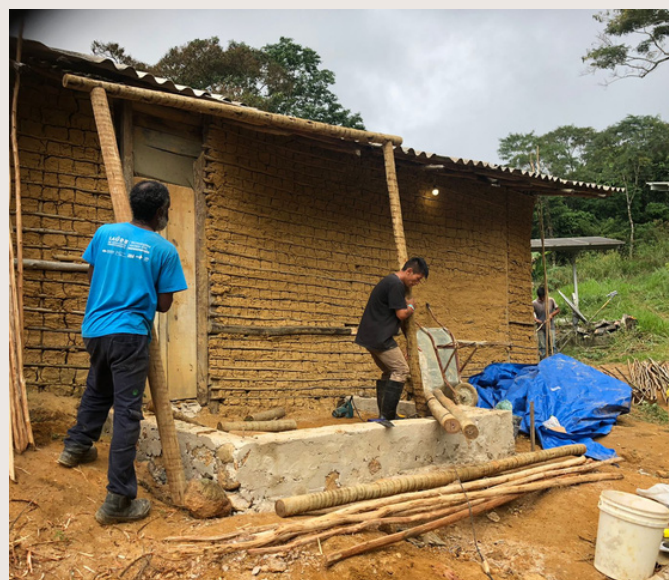
Construção dos banheiros na Aldeia Araponga
