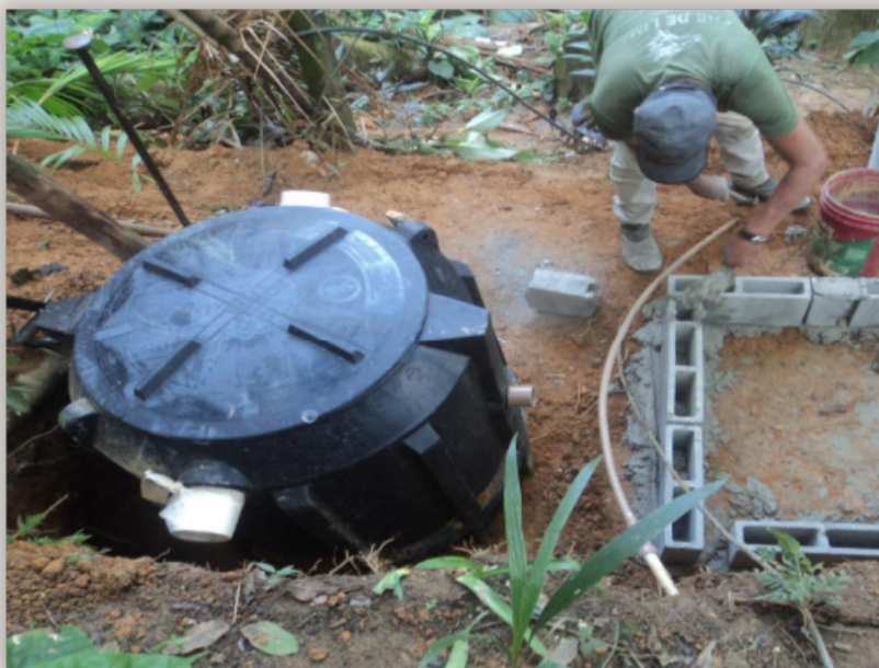
Biodigestores sendo instalados no bairro Retiro em Angra dos Reis
